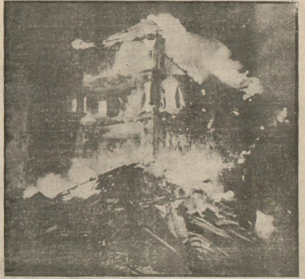
Helsinki'nin bombardmanı esnasında harab olan muazzam bir bina
